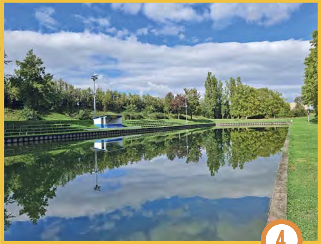
Bassin des joutes • réfection des planches de protection sur les palplanches
