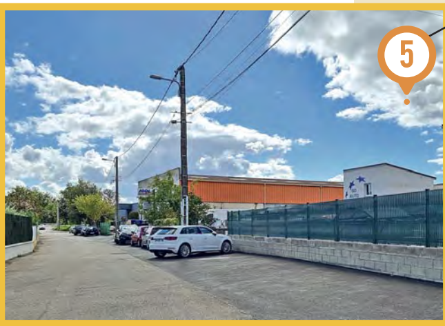
Rue Copernic • réfection des aires de stationnement
