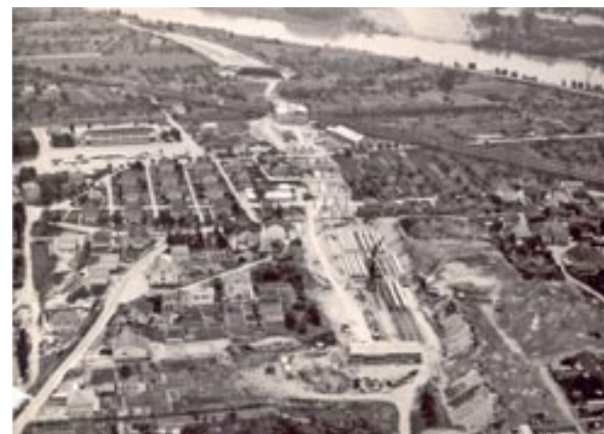
La construction du Viaduc
