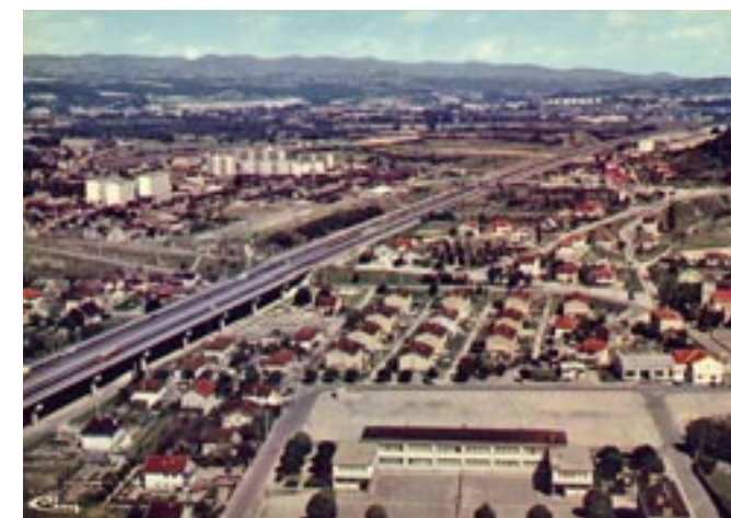
Chasse avec le Viaduc
