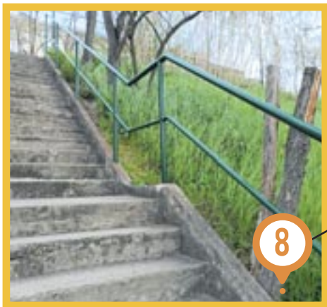
Peinture des barrières d'escaliers
