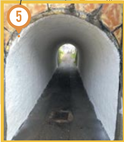
Peinture du pont de la SNCF - Entre Géant et la rue de la Convention
