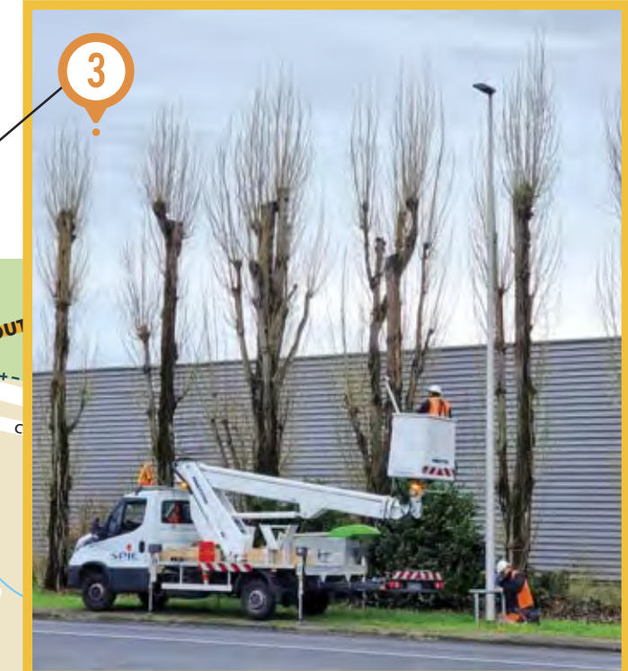
Pause des nouveaux led lumineuses en remplacement de vieux matériaux d'éclairage
