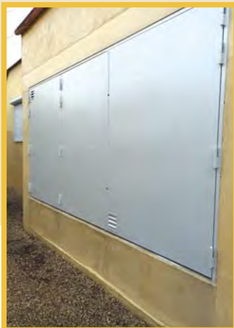
Réfection des peintures de portes et des serrures à la Salle Jean Marion
