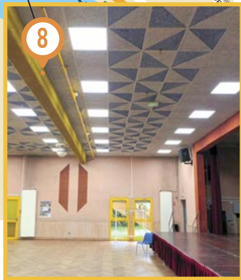
Salle Jean Marion : remplacement des néons par des LEDs.
