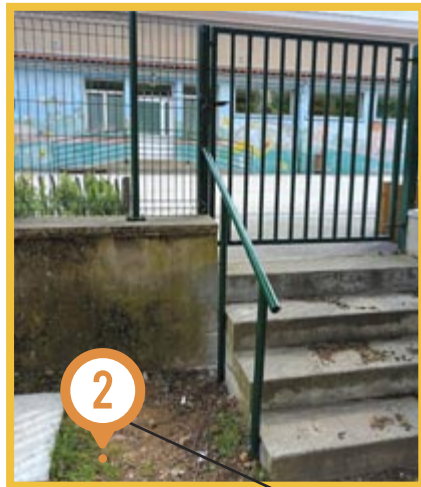
Fabrication et installation d'une nouvelle rampe pour les enfants à l'école du Château.
