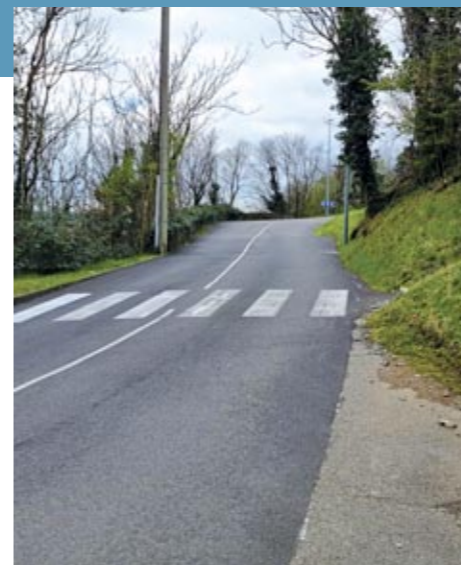
La reprise de la Montée Saint-Martin a été la première rue à bénéficier de ce travail stratégique d'ampleur.
