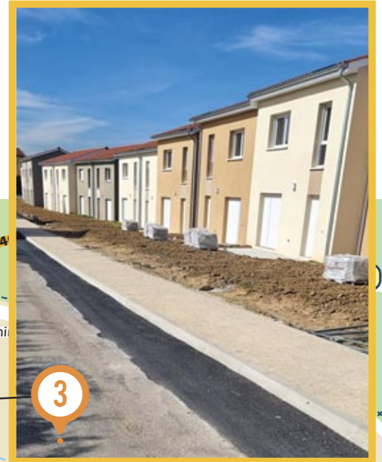
Chemin du lot : travaux d'aménagement pour la création d'un trottoir et la réfection de la voirie.
