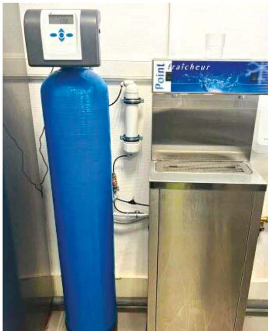
Pour réduire la présence de micropolluants PFAS, un **dispositif de filtration au charbon actif** a été installé dans les cantines des écoles, offrant ainsi aux élèves une eau plus pure. La municipalité veille également à une **surveillance rigoureuse en réalisant des analyses fréquentes de l'eau de consommation**.
