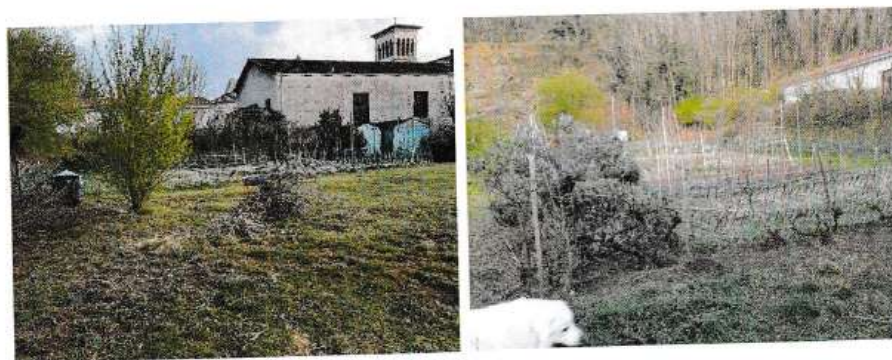
Parcelle 0002, vue vers le sud (parcelle 952, la construction n'apparaît pas dans le plan de zonage et parcelle 953 à l'arrière-plan.
