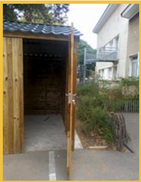
Cabane au Château - Nouvelle cabane dans la cours d'école pour le stockage des jouets d'extérieur.
