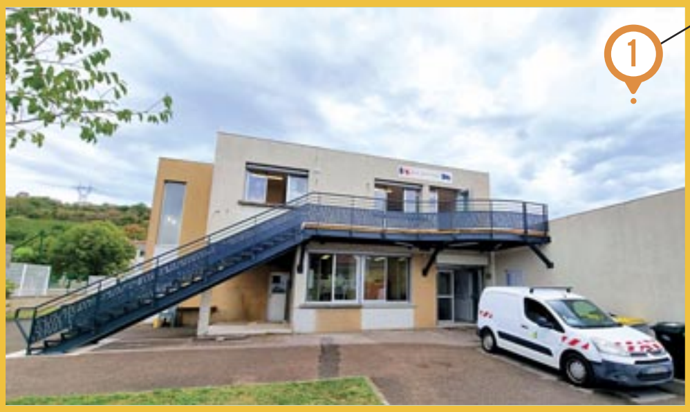
Travaux d'été à l'école des Georgelières - Création d'un sixième espace. Remplacement des menuiseries, remise aux normes pour garantir sécurité et accessibilité.
