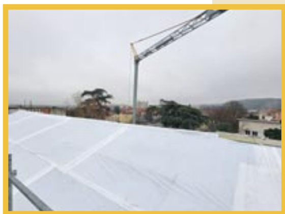
Réfection toiture du château et reprise de l'étanchéité et désamiantage
