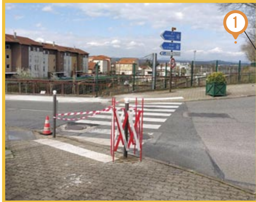
Pont SNCF : Route du 8 mai 1945 : Pose de potelets pour sécurisation du passage piétons
